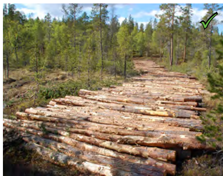
Figur 11: Eksempel på forsterket terreng i form av klopping med tømmerstokker.
