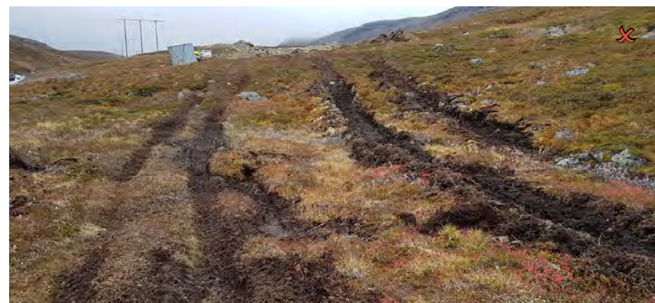
Figur 8: Når det etableres et nytt kjørespor, skal dette benyttes. Entreprenør skal terrengforsterke fremfor å etablere parallele spor.
