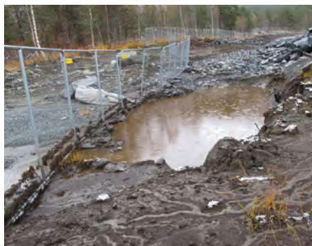
Figur 41: Enkelt sedimentasjonsbasseng for oppsamling av sand og gruspartikler. Viktig at de blir tom regelmessig, for å opprettholde funksjonen.
