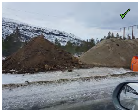
Figur 16: Riktig lagring av vegetasjonsmasser og mineraljord. Massene er lagret i separate ranker/hauger slik at istandsetting kan gjennomføres med vegetasjonsmasser øverst.
