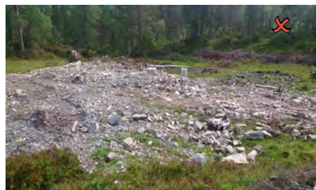
Figur 29: Sprengsteinsblokk på overflaten. Sprengsteinsblokk skal benyttes som tilbakefylling, eller graves ned.
