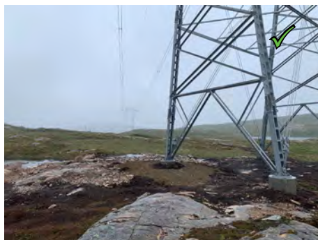
Figur 22: Her er sprengsteinsblokk fjernet fra overflaten.
