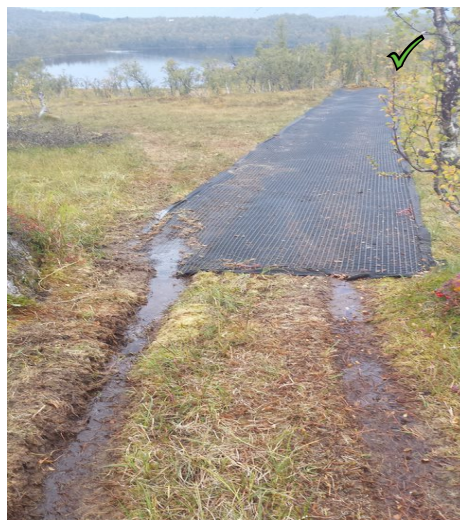
Figur 4: For å unngå kjøreskader over et bløt parti, er terrenget forsterket i forkant.
