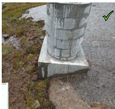
Figur 23: Korrekt utført jording. Ledningen er festet langs fjellet, før den går ned i jord.
