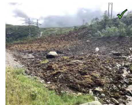
Figur 24: God istandssetting med rufsete overflate og plassering av naturstein på overflaten.
