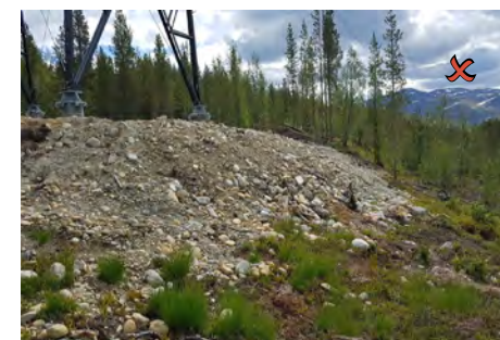
Figur 26: Vegetasjonsmasser er ikke lagt ut som topplag. Selv om det er et område med skrint jordsmonn, må det som er av vegetasjonsmasser tas vare på for istandssetting. Ut-plassering av vegetasjonsstuer ville ha brutt overflaten, og lagt grobunn for raskere naturlig revegetering.
