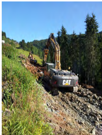
Figur 34: Opprusting av landbruksveg med stedege masser.
