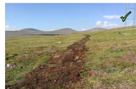
Figur 33: Godt istandsatt kjørespor.
