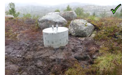
Figur 20: God overgang mellom stabbe og terreng.
