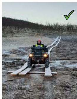
Figur 10: Eksempel på etablert terrengforsterkning over bløte partier.
