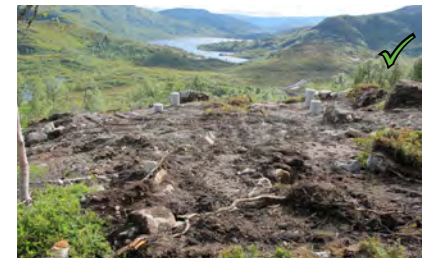
Figur 18: Godt tilbakeført fundament. Overgang mellom fundament og omliggende terreng er ivaretatt på en naturlig måte. Overflaten er rufsete og godt tilrettelagt for naturlig revegetering.
