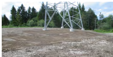
Figur 28: Mastepunkt som er tilbakeført som en stor glatt flate. Her burde flaten vært brutt opp ved å lagd forhøyninger og forsenkninger. I tillegg burde det vært plassert ut vegetasjonstuer for at naturlig veetasjon raskere kan reetableres.
