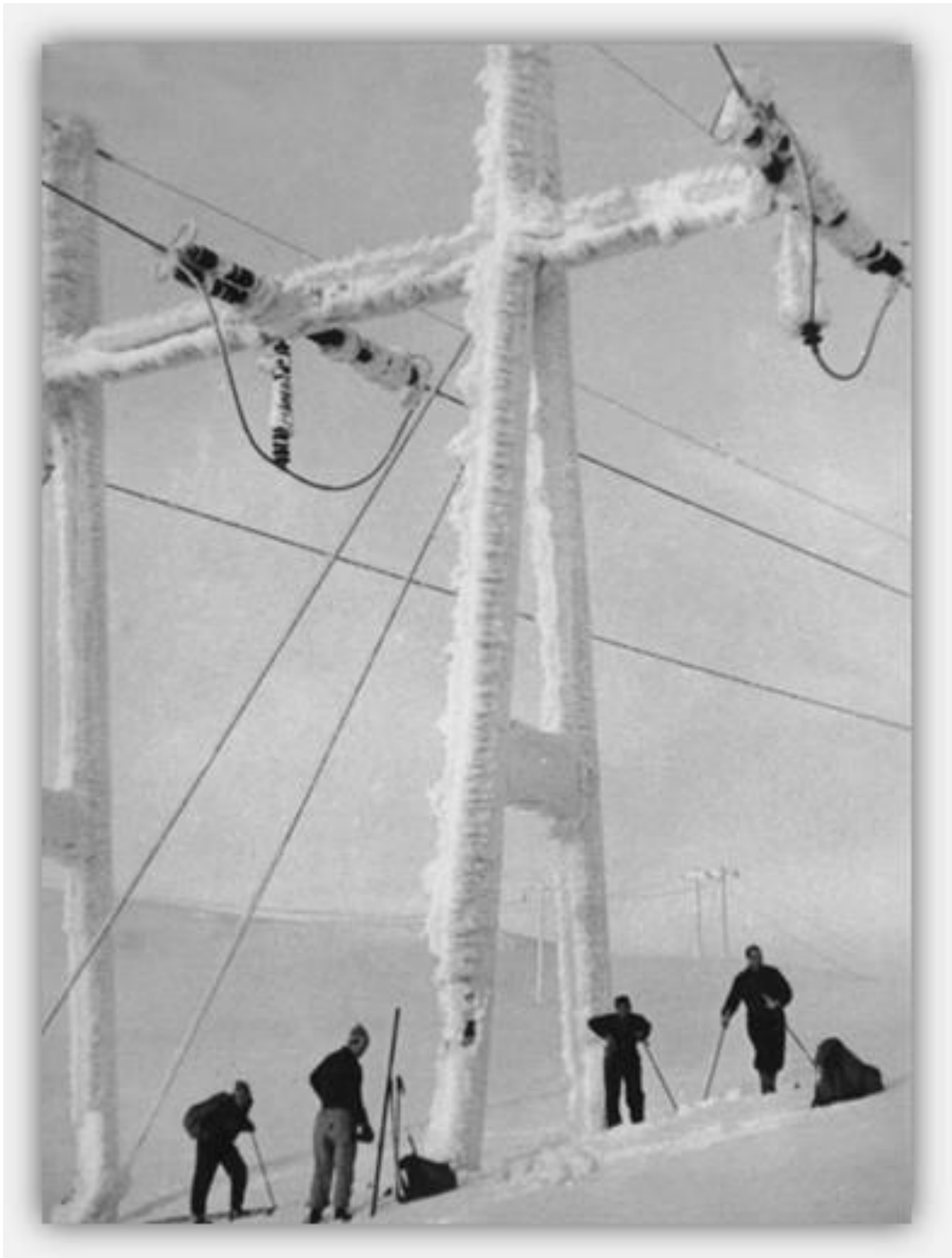
Kraftledningen Nedre Vinstra – Fåberg – Oslo Ledningen var svært viktig for hovedstadens strømforsyning i tidlig etterkrigstid. Dette er Norges høyest spenningsatte betongmastledning. Da den ble satt i drift, var den også landets lengste ledning.
