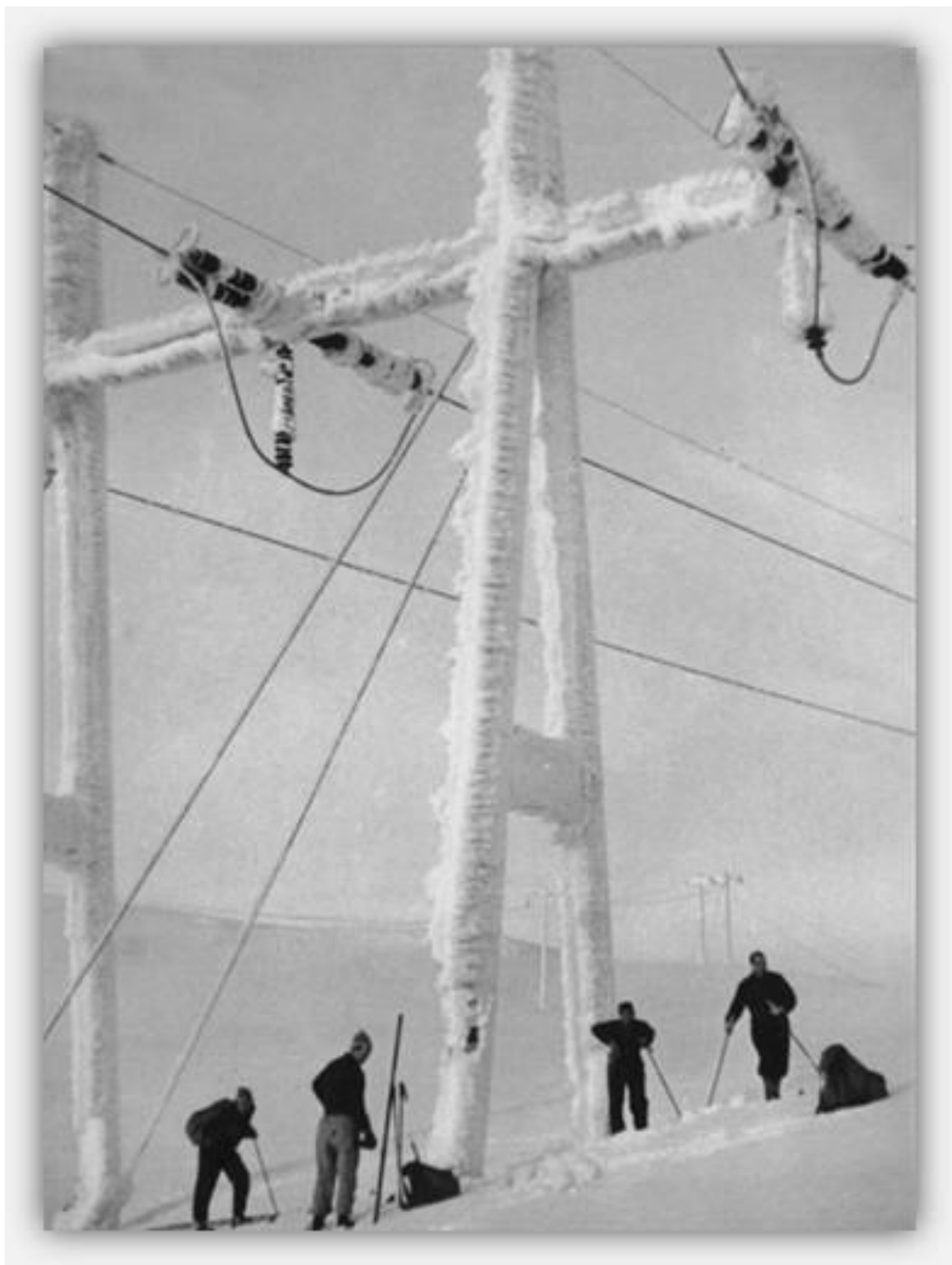
Kraftledningen Nedre Vinstra – Fåberg – Oslo Ledningen var svært viktig for hovedstadens strømforsyning i tidlig etterkrigstid. Dette er Norges høyest spenningsatte betongmastledning. Da den ble satt i drift, var den også landets lengste ledning.
