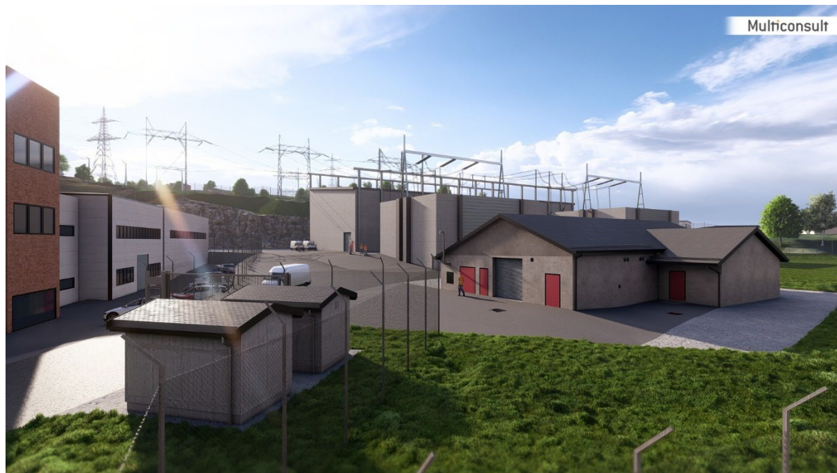
Figur 7: Visualisering av GIS-bygg (lengst bak) og transformatorsjakter, kontrollhus (med røde dører) samt to mindre tekniske bygg (i forgrunnen).
