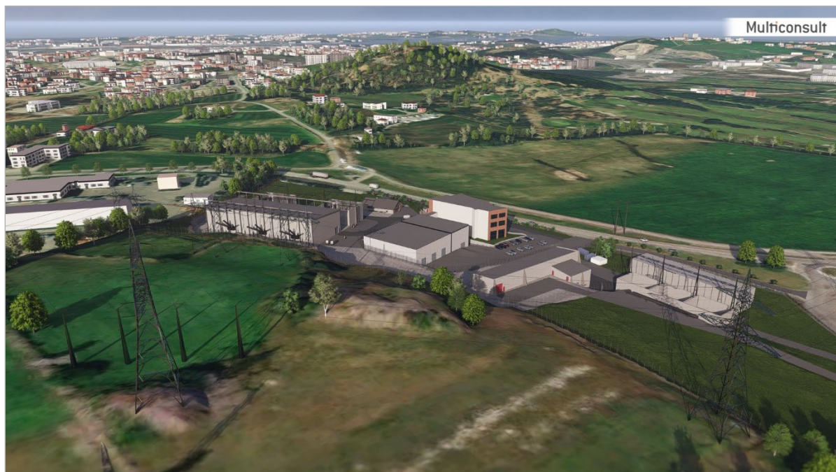
Figur 3: De planlagte enfasemastene og ny dobbeltkursmast, vises henholdsvis nederst til venstre og til høyre i bildet. De nye forankringsmastene kan skimtes sør for Humleberget transformatorstasjon.
