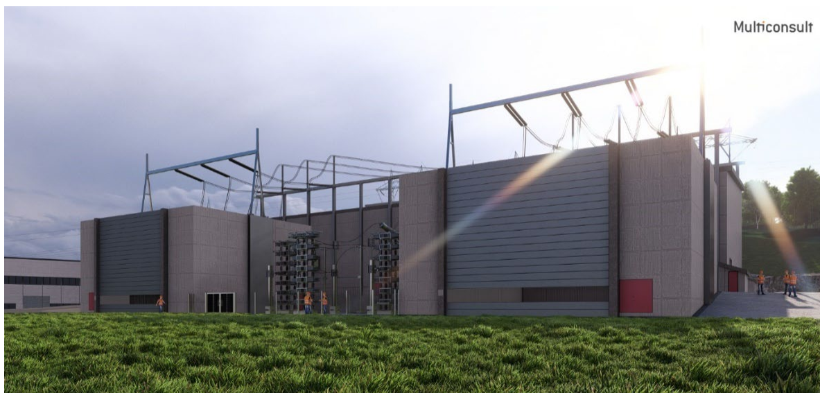
Figur 6: GIS-bygg, kondensatorbatteri og transformatorsjakter i Humleberget transformatorstasjon.
