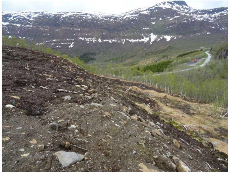
Bilde 1: Deponi ved Kvandal transformatorstasjon
