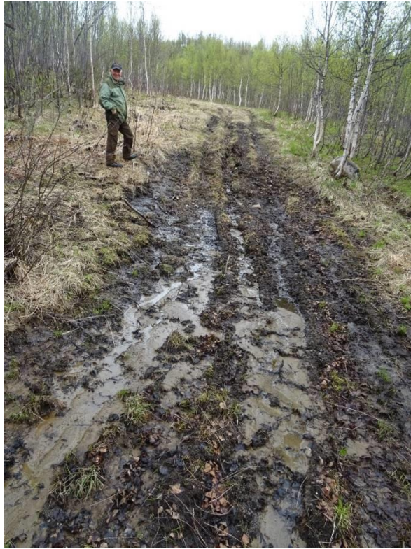
Bilde 11: Første bakke fra veien hvor NVE anbefaler at Statnett gjør tiltak for å gjøre sporet kjørbart.
