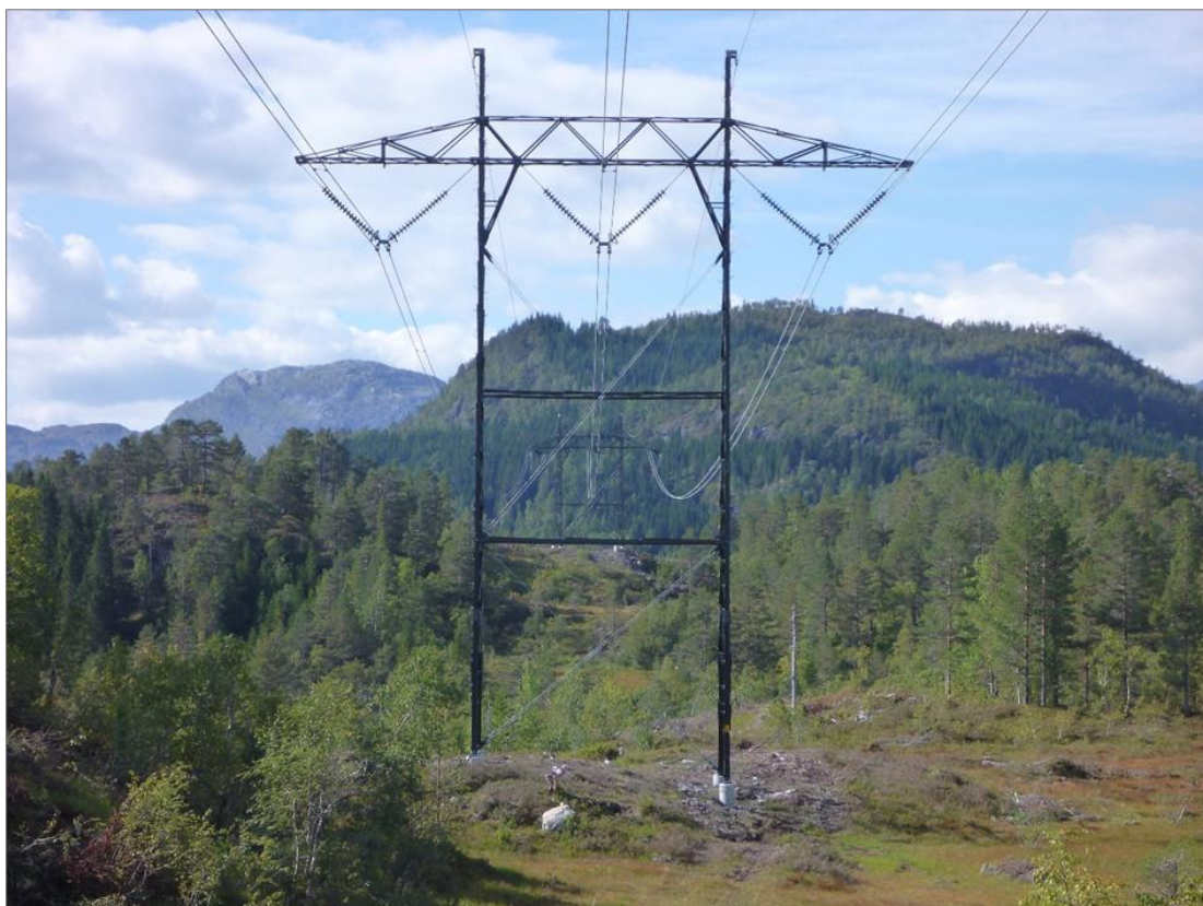
Figur 16. 420 kV bæremast. Ledningen er kamuflert med mørk grønn farge i kombinasjon med begrenset skogrydding (neste mast kan skimtes midt inne i masta).
