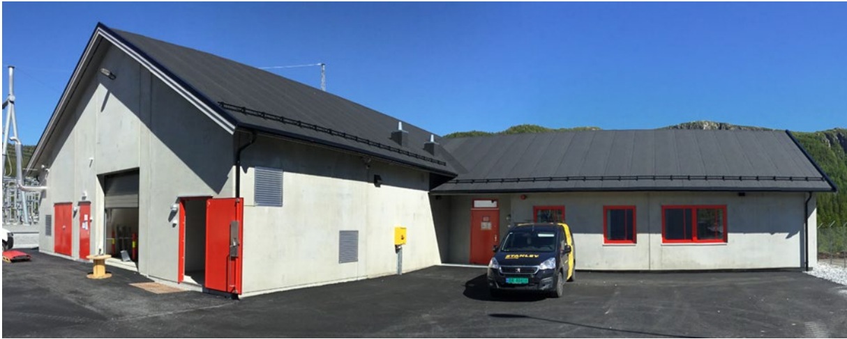
Figur 6: Eksempel på kontrollbygg for Statnett. Her fra Hofstad transformatorstasjon.
