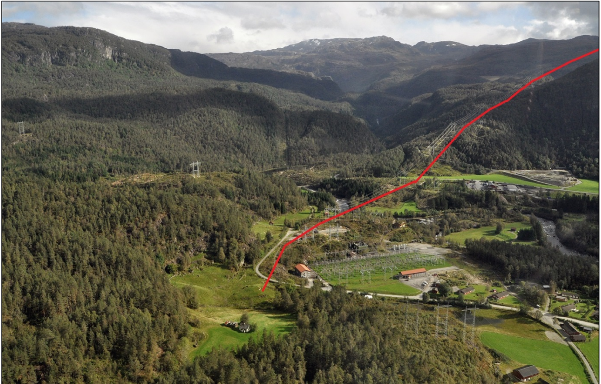
Figur 3. Suda transformatorstasjon. Trasé for planlagt 420 kV-ledning Suda-Lyse er markert med rødt strek.
