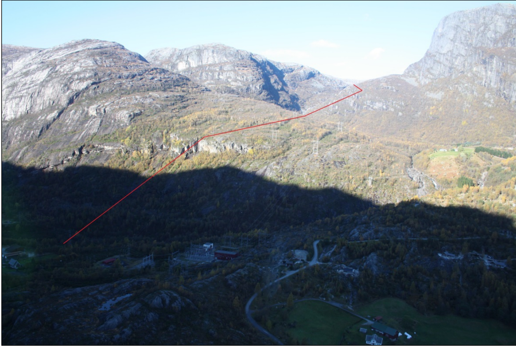
Figur 10. Planlagt trasé for ny 420 kV-ledning Sauda-Lyse ned til Lyse transformatorstasjon, sett fra sør.
