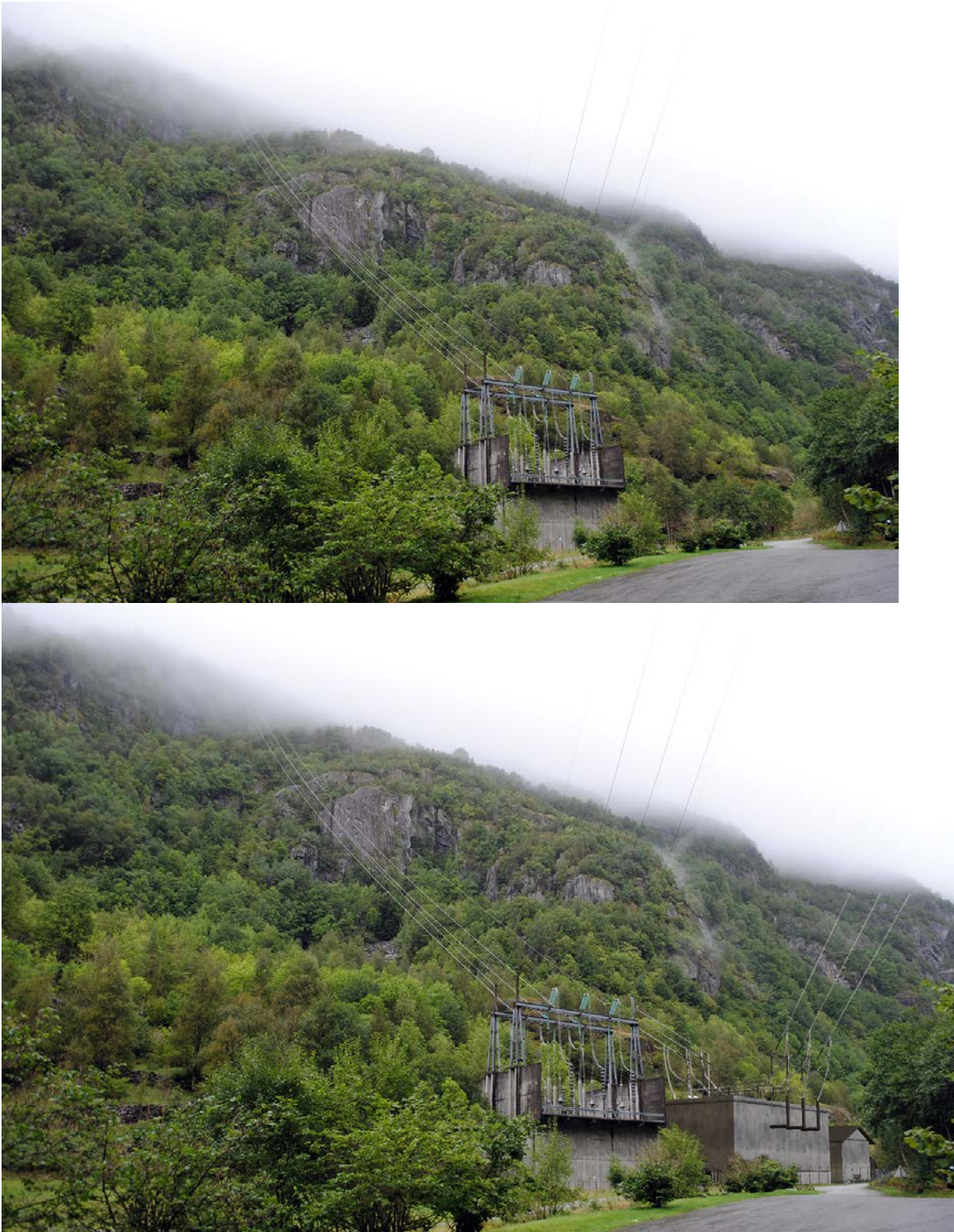
Figur 69. Bildet viser utvidelse av eksisterende GIS anlegg i Hylen.
