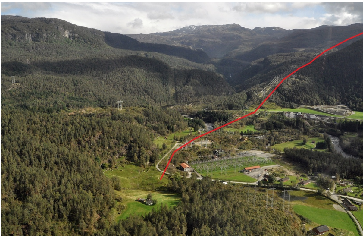
Figur 4. Suda transformatorstasjon. Trasé for planlagt 420 kV-ledning Suda-Lyse er vist med rød strek.
