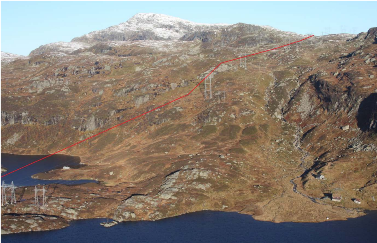
Figur 6. Tengedalsstølen, helt til høyre i bildet, sett mot nord. Ny ledning vil komme på bortsiden av eksisterende ledninger, sett fra stølen. Den nærmeste ledningen rives.
