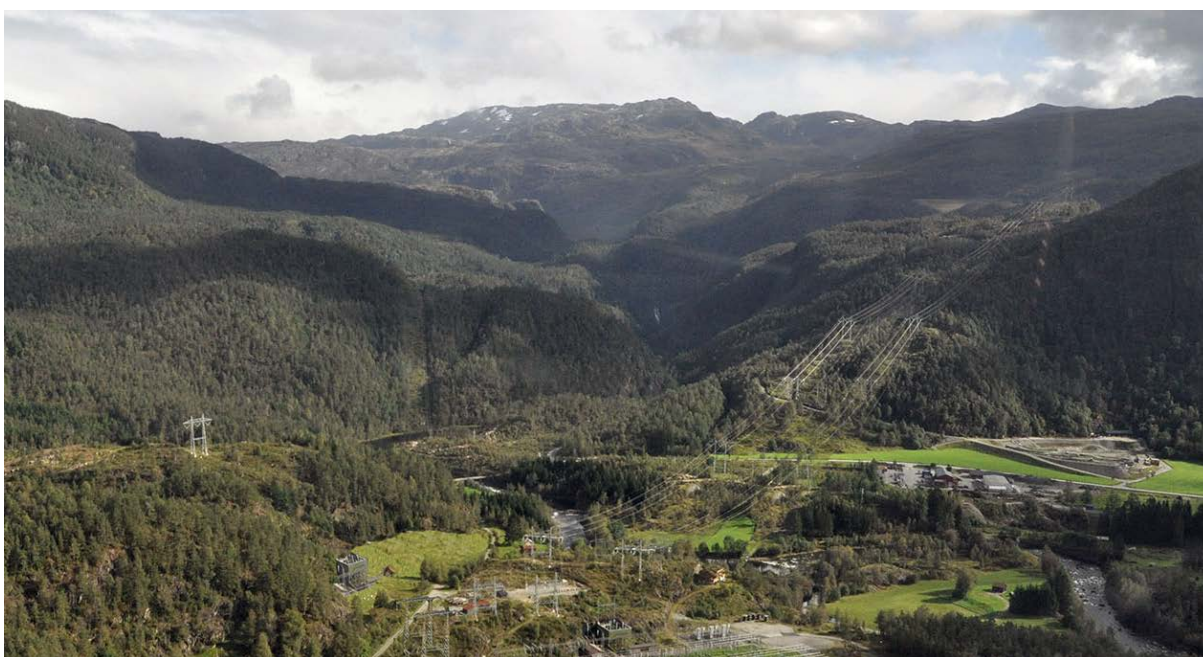
Figur 36 Manipulert nedre bilde viser tydeligere linjer der ny 420kV linje har erstattet eksisterende 300kV linje.
