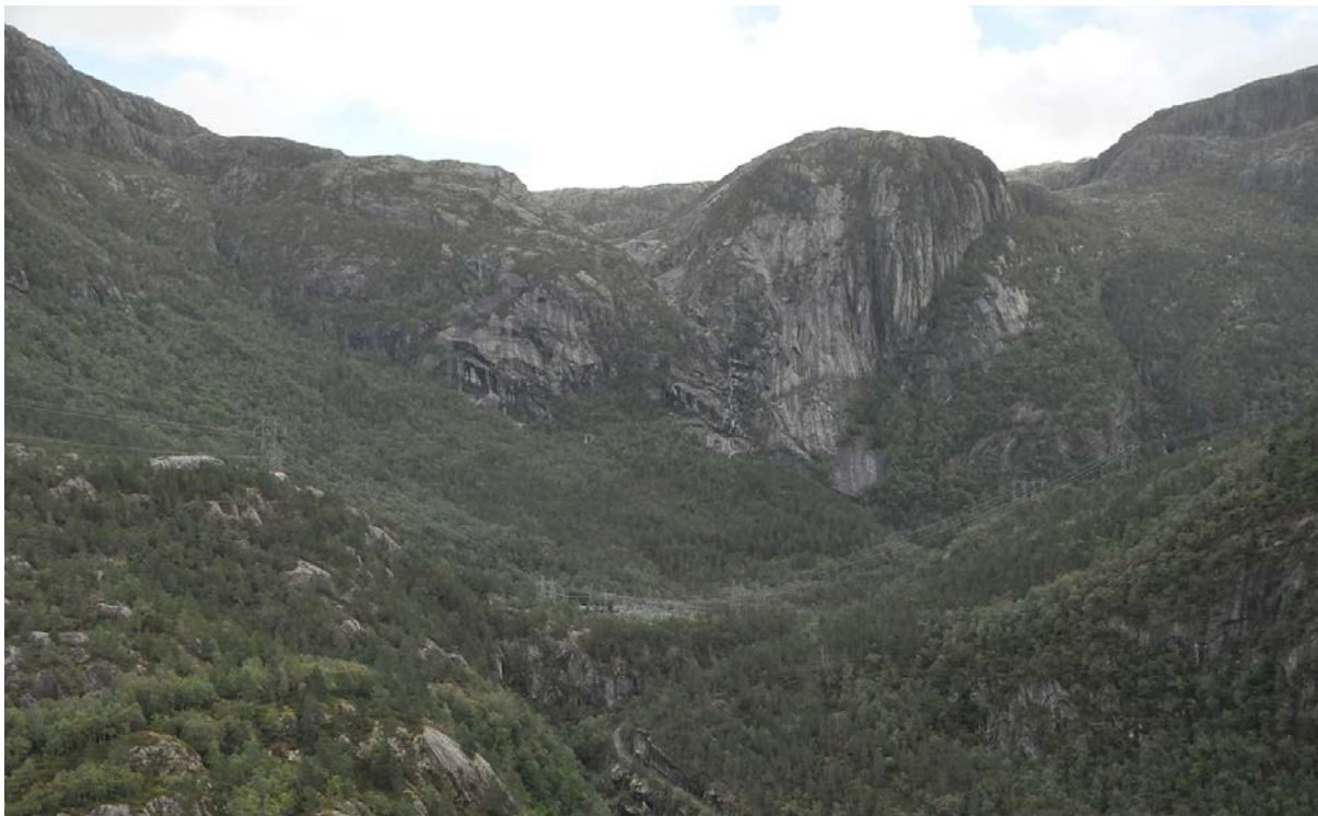
Figur 29. Bildet viser eksisterende transformatorstasjon liggende noe avskjernet til i en hengedal sør for hoveddalføret og Førrejuvet.
