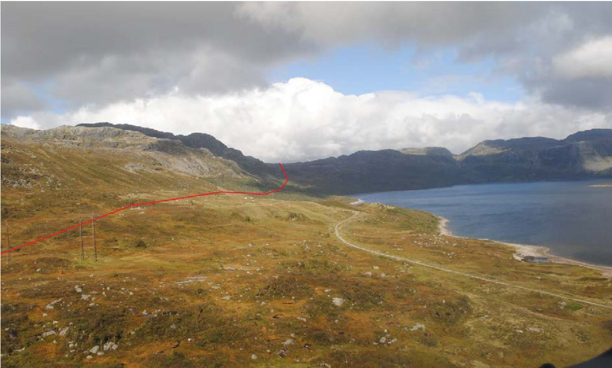
Figur 9. Sandsavatnet sett mot nord. På denne strekningen vil den nye ledningen bli bygget på vestsiden av eksisterende ledning Lyse-Saurdal.
