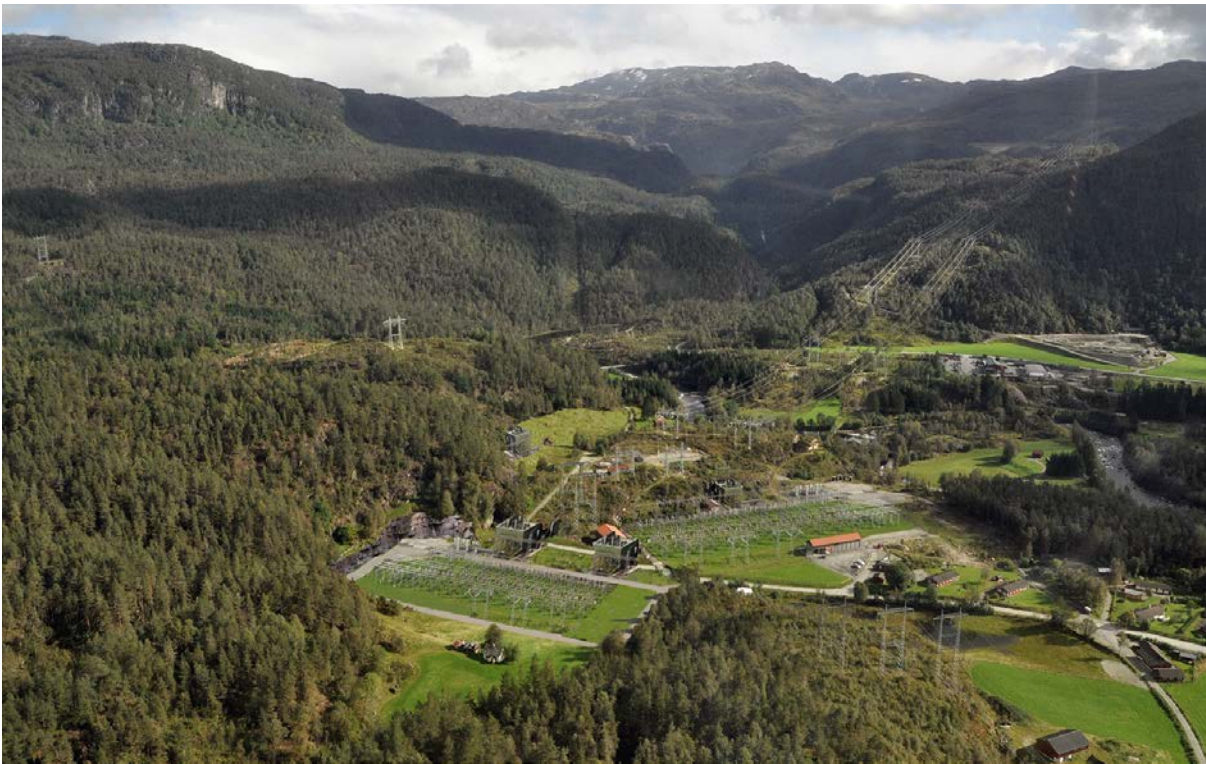
Figur 67. Bildet viser arealet som vil bli berørt ved utvidelse av Suda transformatorstasjon mot nordvest. Arealet ligger skjermet til og transformatorstasjonen antas å få liten synlighet.
