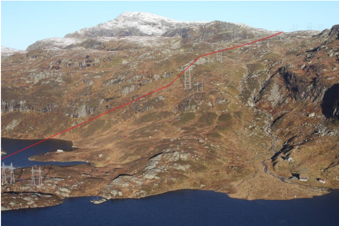
Figur 4-4. Tengesdalsstølen, helt til høyre i bildet, sett mot nord. Ny ledning vil komme på bortsiden av eksisterende ledninger, sett fra stølen. Den nærmeste ledningen rives.
