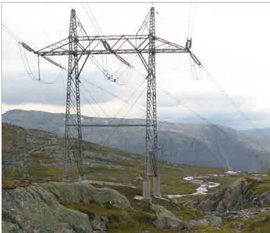
Figur 17. 420 kV forankringsmast
