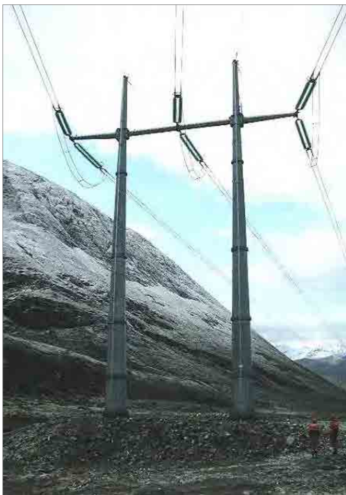
Figur 21. 420 kV skredmast (forankringsmast)
