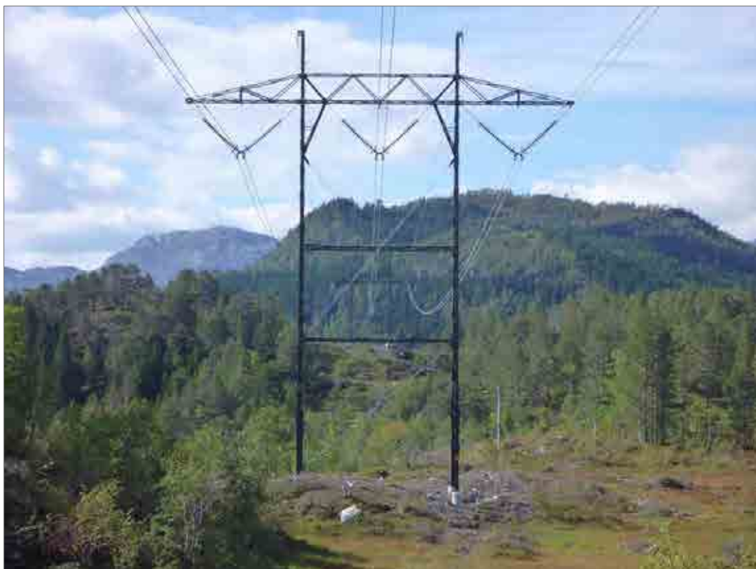
Figur 16. 420 kV bæremast. Ledningen er kamouflert med mørk grønn farge i kombinasjon med begrenset skogrydding (neste mast kan skimtes midt inne i masta).
