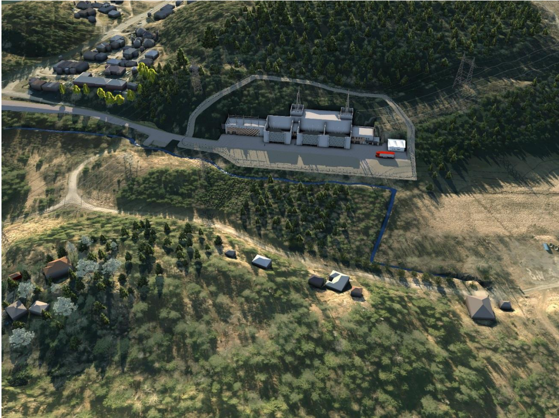
Figur 1: Oversiktsbilde over stasjonsalternativ B. Bildet er tatt fra øst.
